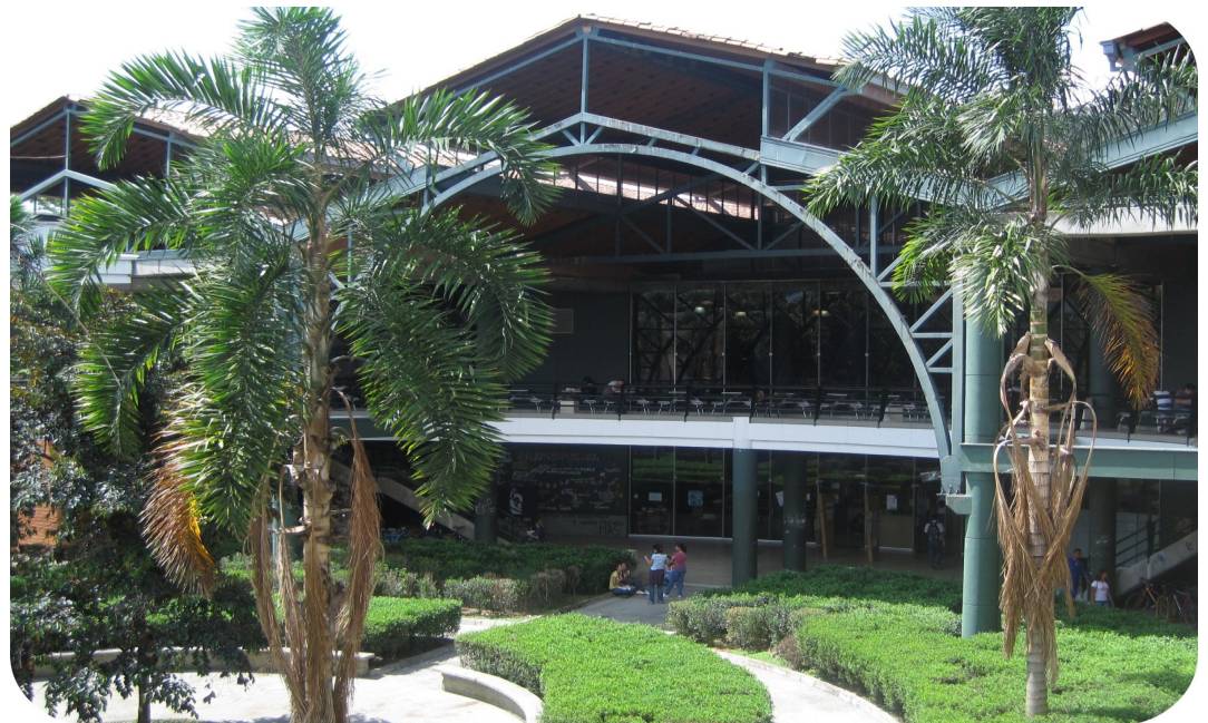
Fachada Biblioteca Efe Gómez.
